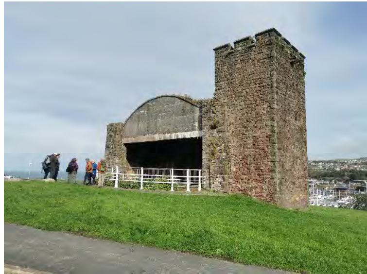
Duke Pit fan house
